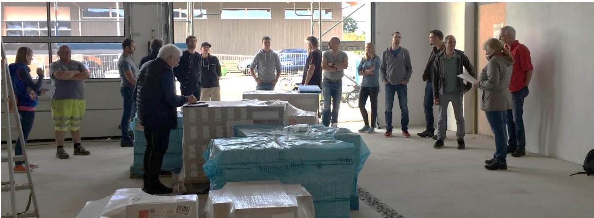
Besichtigung des Baufortschritts Zusammen mit dem Gemeinderat und der Feuerwehr am 17.07.2020
