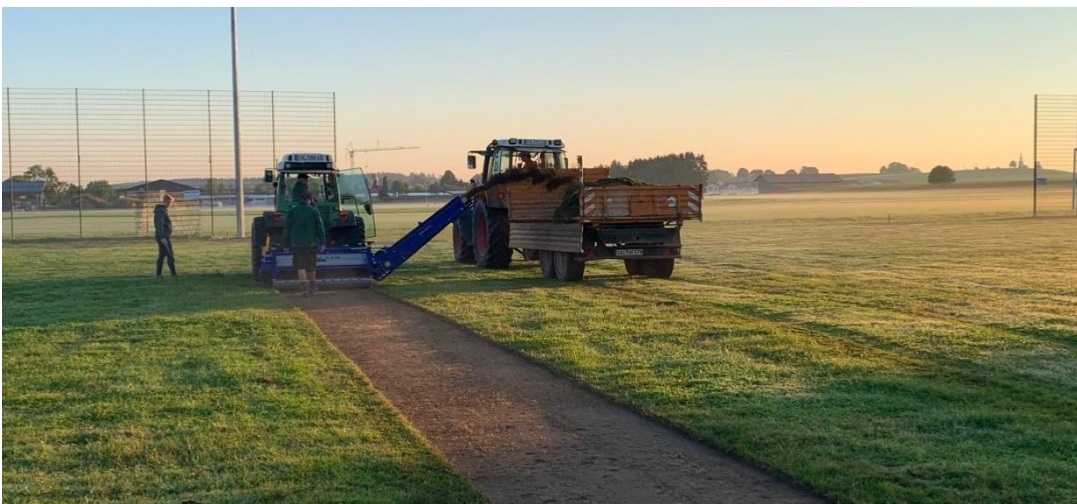
Abfräsen des alten Rasens
