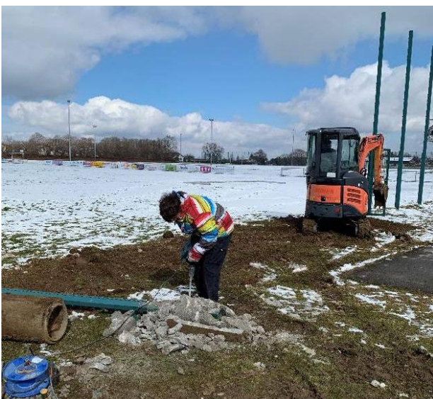
Abbau des alten Fangzauns
