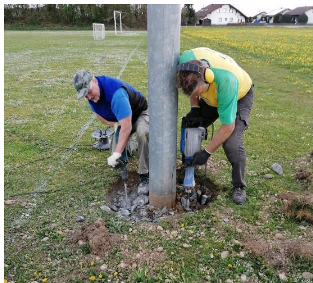
Abbau der alten Flutlichtmasten
