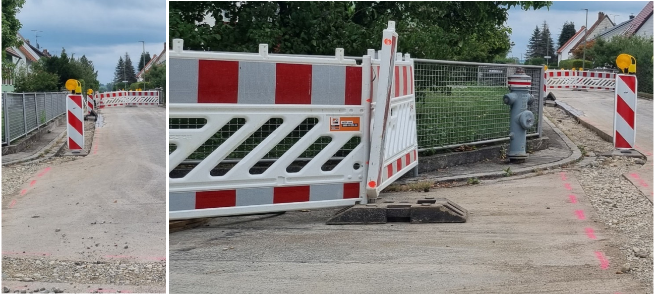
Baustellen über Baustellen: Glasfaserausbau in allen Straßen!
