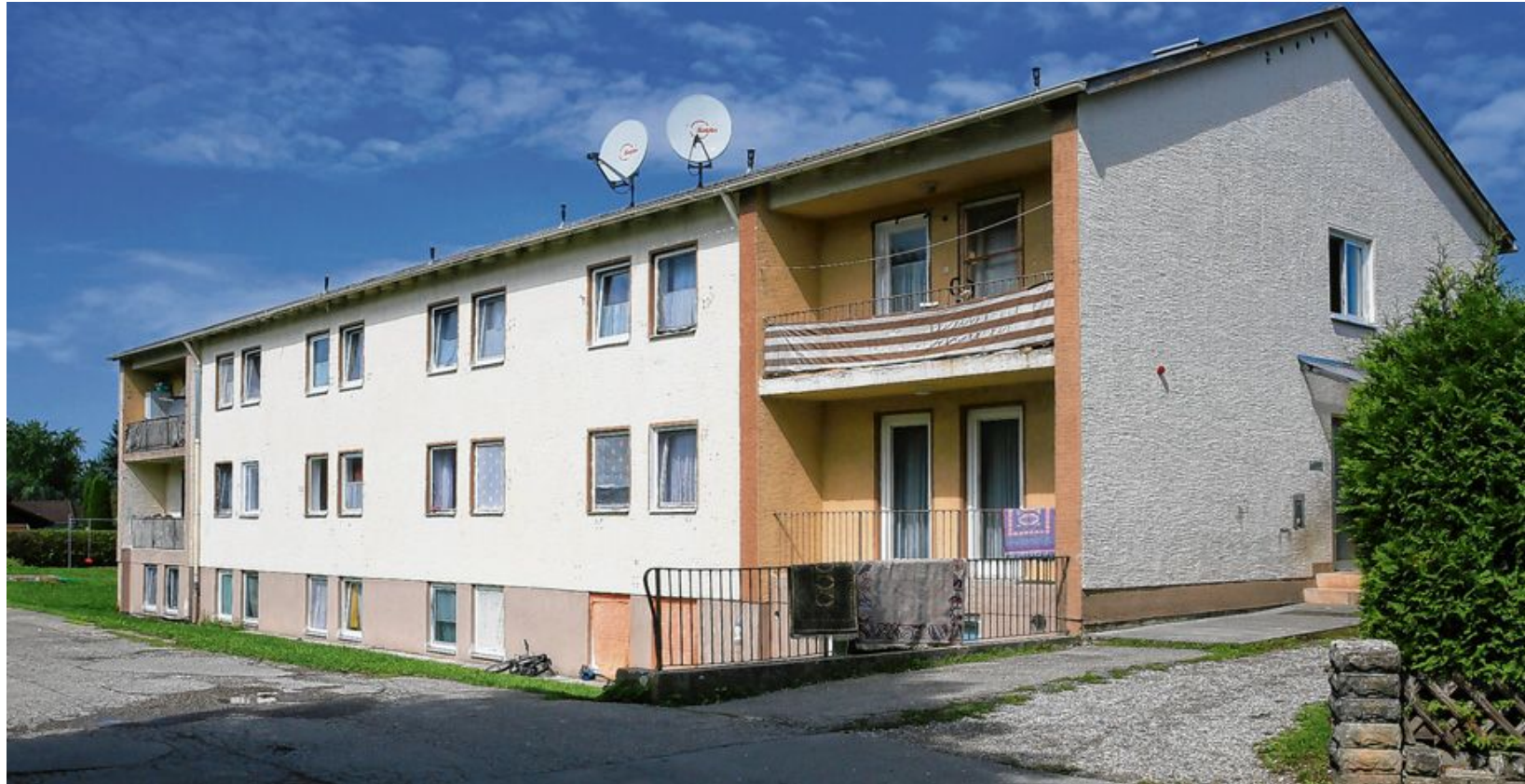
Einst diente dieses Gebäude in Zellerberg als Arbeiterwohnheim einer Maschinenfabrik, seit 1980 hat es die Regierung von Schwaben als Unterkunft für Asylbewerber angemietet. Die Gemeinde fordert nun, dass es bis Ende des Jahres geräumt und geschlossen wird.
