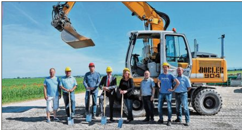
Beim Spatenstich des Baugebiets „Grabenäcker Süd“ im Riedener Südosten. Foto: Klaus D. Treude
