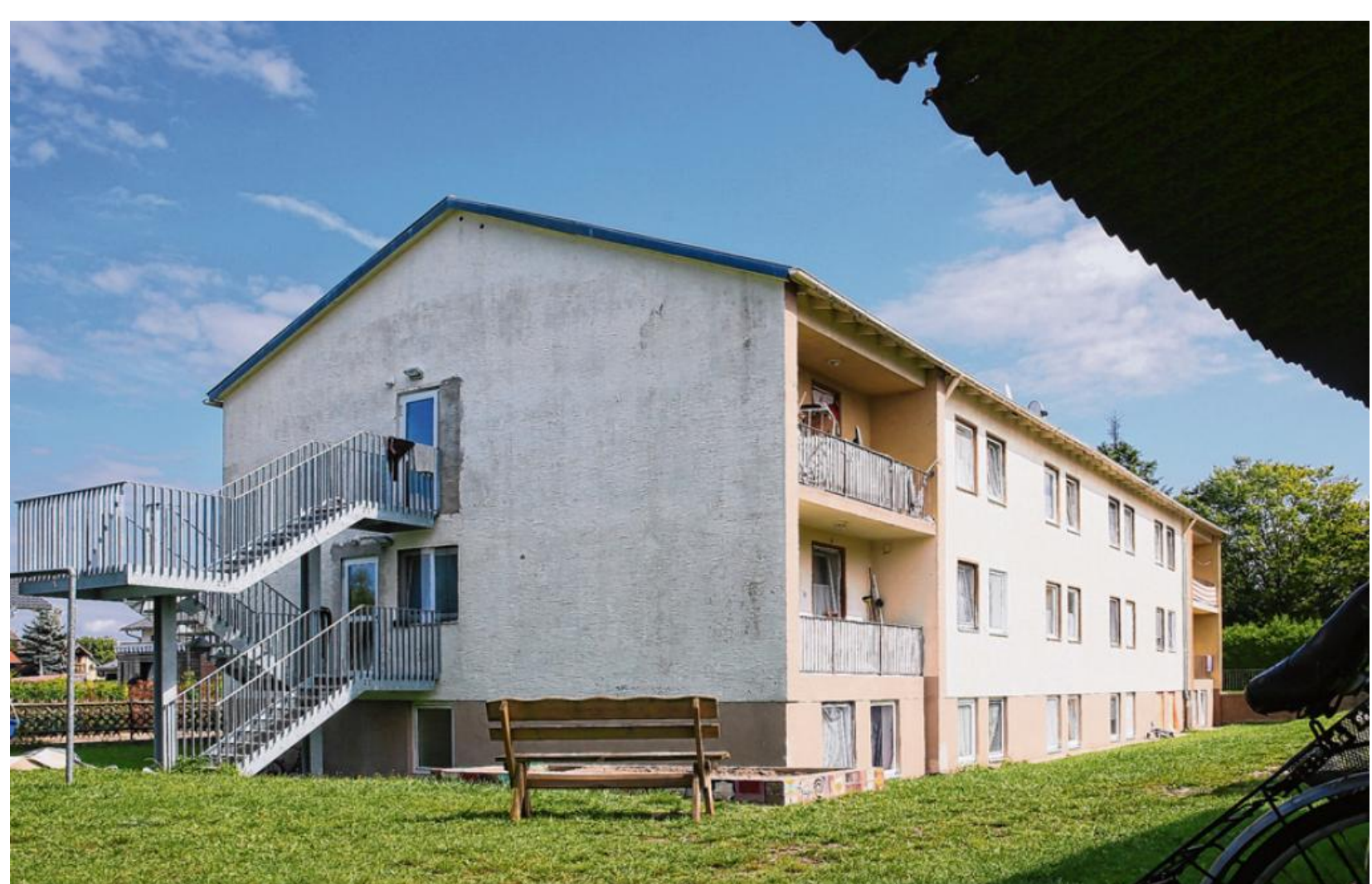
Das ehemalige Arbeiterwohnheim einer Maschinenfabrik dient seit 1980 als Unterkunft für Asylbewerber. Ende 2018 soll diese nun schließen. Derzeit leben dort noch über 54 Menschen. Archiv-Foto: Wild
