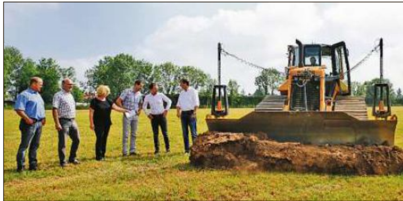
Der Spatenstich im Gewerbegebiet Rieden Süd.
